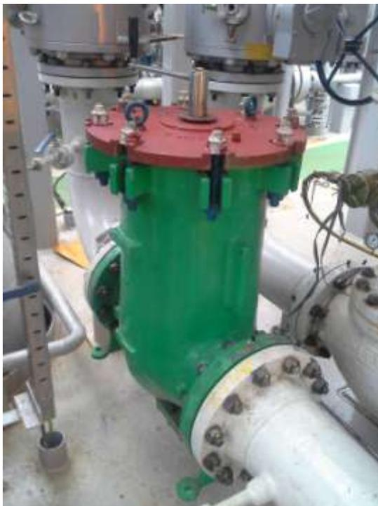
Figura 14 – Filtro suportado pela tubulação
